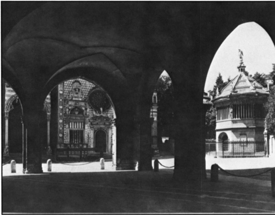
13 View through open arcaded ground level of the Palazzo della Ragione and toward the Piazzetta del Duomo, Città alta, Bergamo (photo: Alinari)
