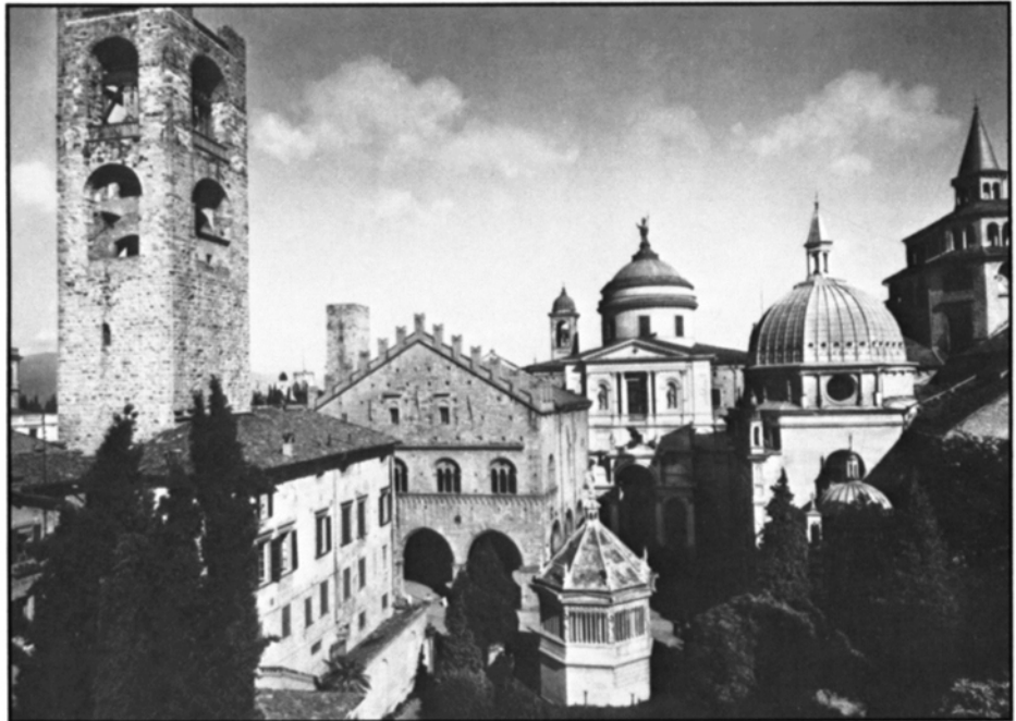
20 Palazzo della Ragione between piazza and piazzetta, Città alta, Bergamo (photo: Alinari)
